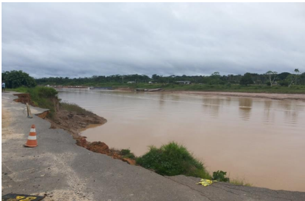
Foto 05: Trecho da estrada localizada no município de Rodrigues Alves, onde passará a LT.
